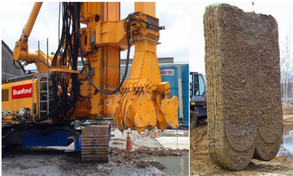
شکل ۳-۶۷ ماشین اختلاط عمیق خاک برنده که سبب ترکیب خاک و سیمان در راستای قائم می‌شود و ستون خاک - سیمانی نهایی به شکل مستطیل خواهد بود.
