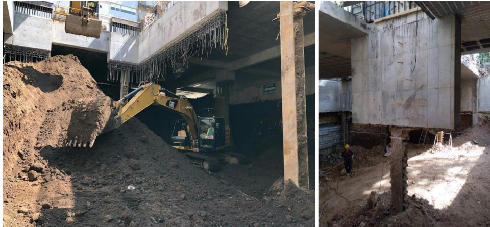
شکل ۳-۱۰۷ اجرای از بالا-پایین دیوار برشی و استفاده از یک عضو باربر قائم در دیوار به منظور انتقال نیروها به شمع
