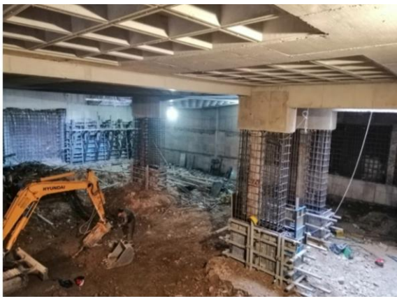
شکل ۱-۱۴ پروژه شریعتی، فلسفی- الگوی بومی - اسکلت مختلط بتنی - فولادی (SRC) - عمق گودبرداری ۳۴ متر
