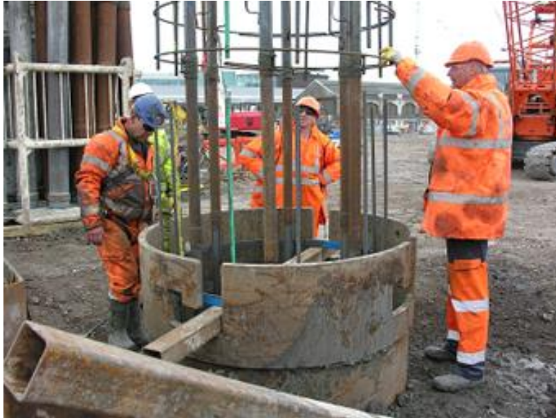
شکل ۳-۴۵ استفاده از غلاف فولادی در سر چاه جهت نصب و وصله شبکه میلگرد شمع.
