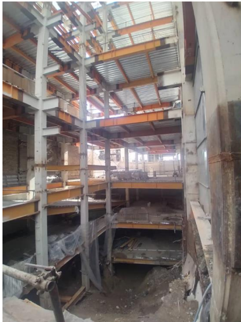
شکل ۱-۱۶ پروژه پاسداران - الگوی بومی - اسکلت فلزی- سقف عرشه فولادی- عمق گودبرداری ۱۸ متر.
