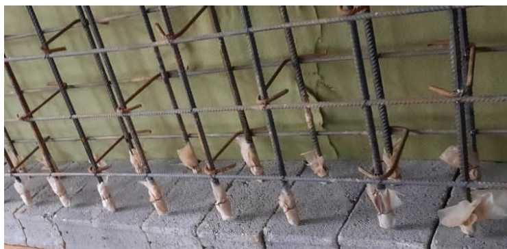
شکل ۳-۹۸ محافظت از وصله مکانیکی (کوپلر) با پوشش پلاستیکی جهت جلوگیری از گرفتگی وصله و خراب شدن رزوه
