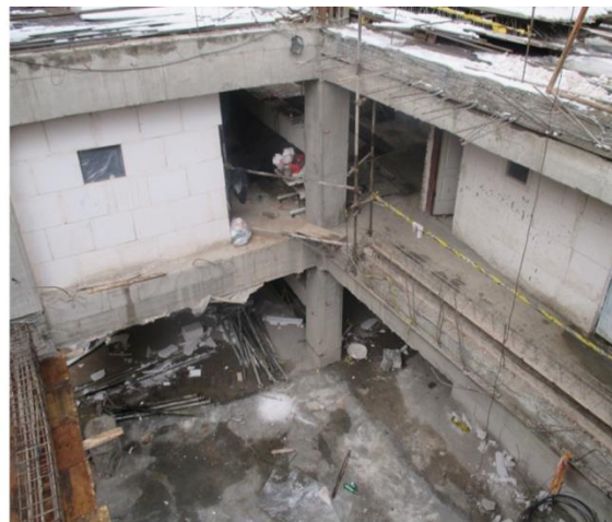
شکل ۱-۱۷ پروژه دیباجی جنوبی - الگوی بومی - اسکلت بتنی با ستونهای درجاریز- عمق گودبرداری ۱۴ متر
