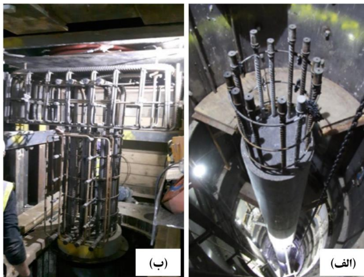
شکل ۳-۳۹ نمونه‌ای از اجرای ستون بتنی داخل چاه و از پایین به بالا؛ (الف) بتن‌ریزی مرحله به مرحله ستون از پایین به سمت بالا و مهار ستون ریخته شده به دیواره چاه - (ب) قرار دادن میلگردهای انتظار با اتصال مکانیکی (کوپلر) جهت اتصال ستون به تیر
