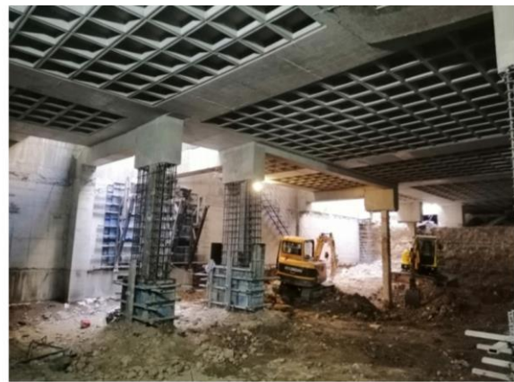
شکل ۱-۱۴ پروژه شریعتی، فلسفی- الگوی بومی - اسکلت مختلط بتنی - فولادی (SRC) - عمق گودبرداری ۳۴ متر
