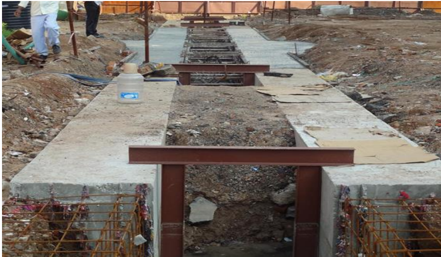
شکل ۳-۵۶ آماده سازی دیواره هادی در سر ترانشه پیش از آغاز حفاری
