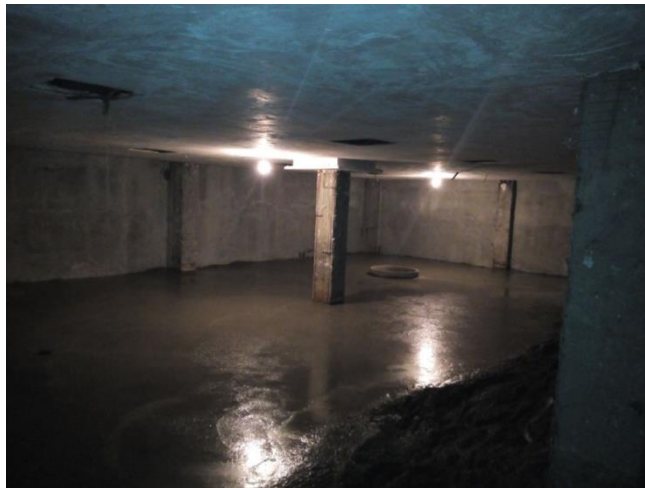
شکل ۳-۱۲۶ نمونه اجرای بتن آب‌بند بر روی فونداسیون
