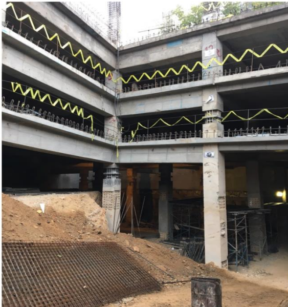
شکل ۱-۱۳ پروژه پارکینگ طبقاتی نیاپش - الگوی بومی - اسکلت بتنی با ستون‌های پیش‌ساخته - عمق گودبرداری ۳۵ متر
