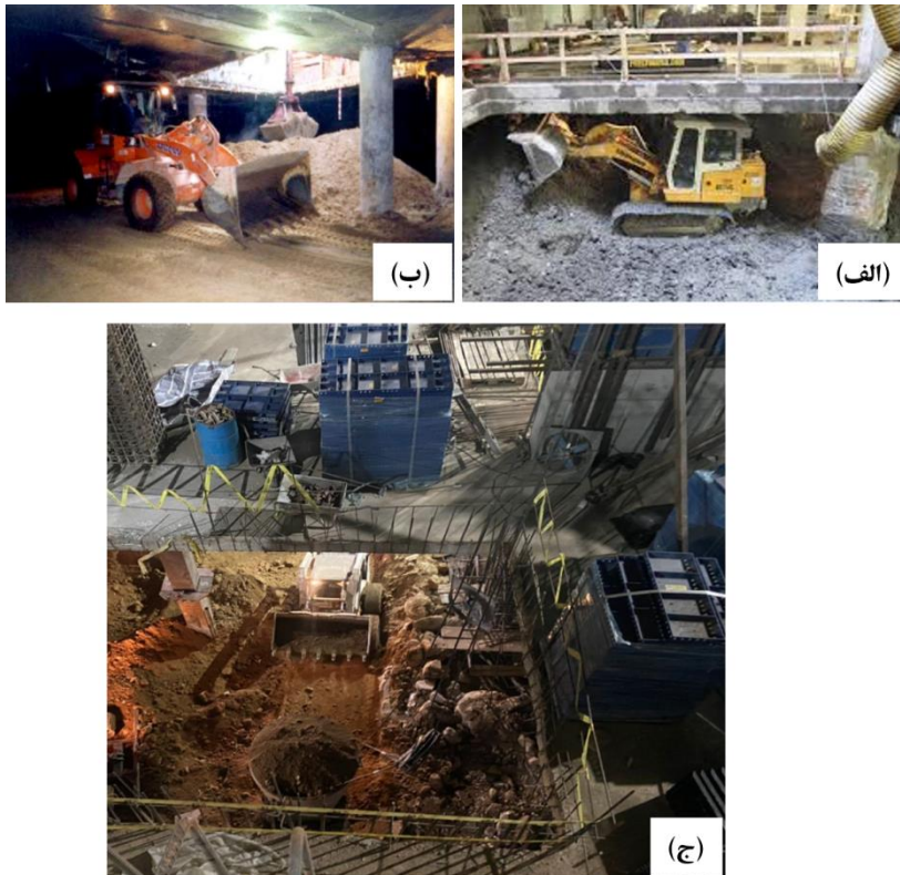
شکل ۳-۷۲ الف) مینی‌لودر در فضای کاری تنگ زیر سقف در روش بالا-پایین و ب) لودر جهت جابجایی خاک در روش بالا-پایین زیر تراز سقف و انتقال خاک به محل بازشو خروج خاک.
