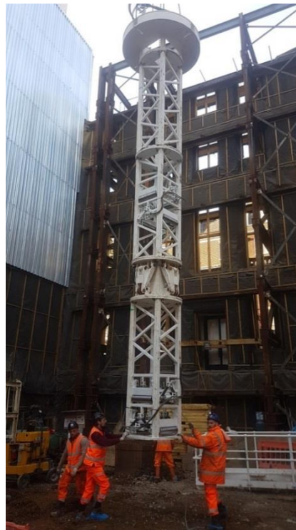
شکل ۳-۱۹ نمونه‌ای از سکوی سرچاهی جهت نصب ستون‌های معلق در روش ساخت بالا-پایین در خارج از کشور که دارای جک‌های هیدرولیکی و سیستم پایش و تراز دقیق و دیجیتالی می‌باشد.
