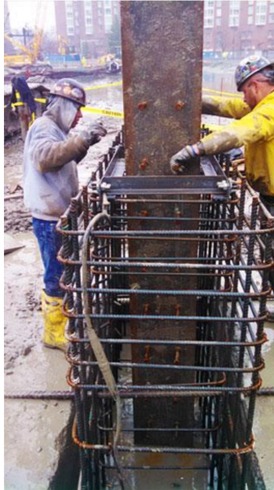
شکل ۳-۴ نصب شبکه میلگرد دیوار دیافراگمی به کمک دیواره هادی و معلق نگه داشتن قطعه تحتانی در سر ترانشه جهت وصله به قطعه فوقانی
