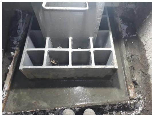
شکل ۳-۲۷ نصب و ملات‌ریزی ستون دارای کف‌ستون بر روی بولت‌های مهار شده در شمع
