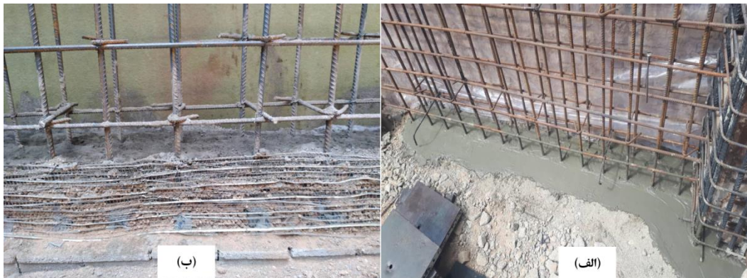
شکل ۳-۹۷ محافظت از طول مورد نیاز انتظار در پایین دیوار حائل برای وصله میلگردهای طولی به میلگردهای طولی دیوار طبقه پایین، (الف) حفر کانال پای دیوار و جایگذاری میلگردهای اصلی و پر کردن کانال با خاک و استفاده از پوشش ماسه و سپس یک لایه نازک دوغاب سیمان، (ب) محافظت از طول میلگرد پایین‌تر از تراز پایین دیوار حائل به وسیله رابیتس و پر کردن طول وصله با خاک، یک لایه ماسه و دوغاب نازک سیمان
