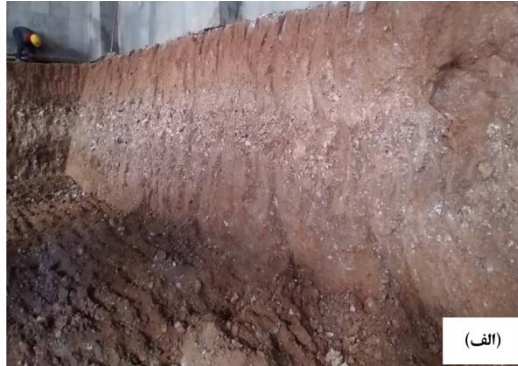
شکل ۳-۹۴ الف) قطعه‌برداری از دیواره خاکی گود و تسطیح و آماده‌سازی دیواره گود پیش از اجرای دیوار حائل، ب) اجرای عایق در روی دیواره گود پیش از اجرای دیوار حائل.
