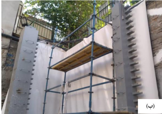
شکل ۳-۹۴ الف) قطعه‌برداری از دیواره خاکی گود و تسطیح و آماده‌سازی دیواره گود پیش از اجرای دیوار حائل، ب) اجرای عایق در روی دیواره گود پیش از اجرای دیوار حائل.
