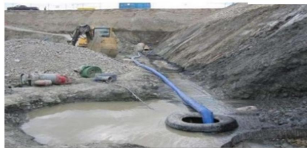
ج - نمونه یک حوضچه پمپاژ کارگاهی
