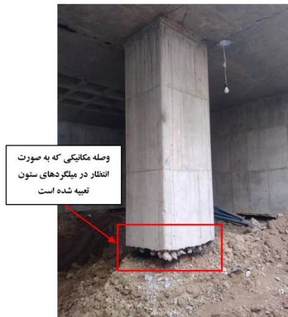
شکل ۳-۳۶ مقطع نهایی اجرا شده ستون مختلط بتنی
